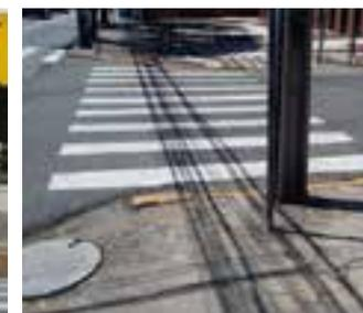
Travessia sem rampa e obstruída por poste.
