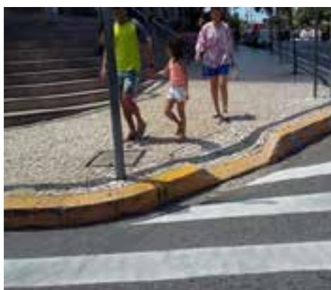
Passeio com dimensões adequadas, porém rampa de acesso inviável.
