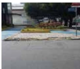
Inexistência de rampa na travessia e piso degradado
