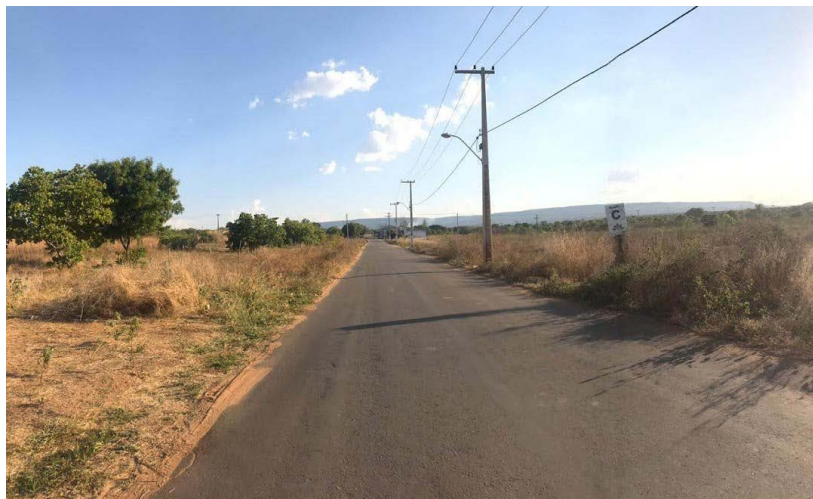
Figura 3. Único acesso ao Conjunto Residencial Pedro Raimundo da Cruz pela rodovia CE-293.
