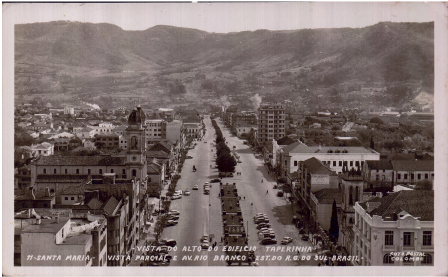
Figura 4: Cartão-postal com foto captada do alto do Edifício Taperinha.
