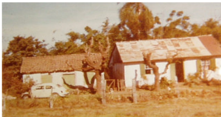
Foto 1: vista da casa do Sr. Ewerling antes da restauração.
