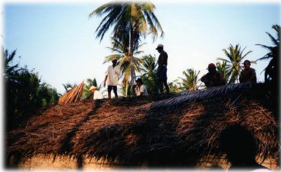
Imagen 8 – Voluntarios reconstruyen el techo de la Escola Alegria do Mar
