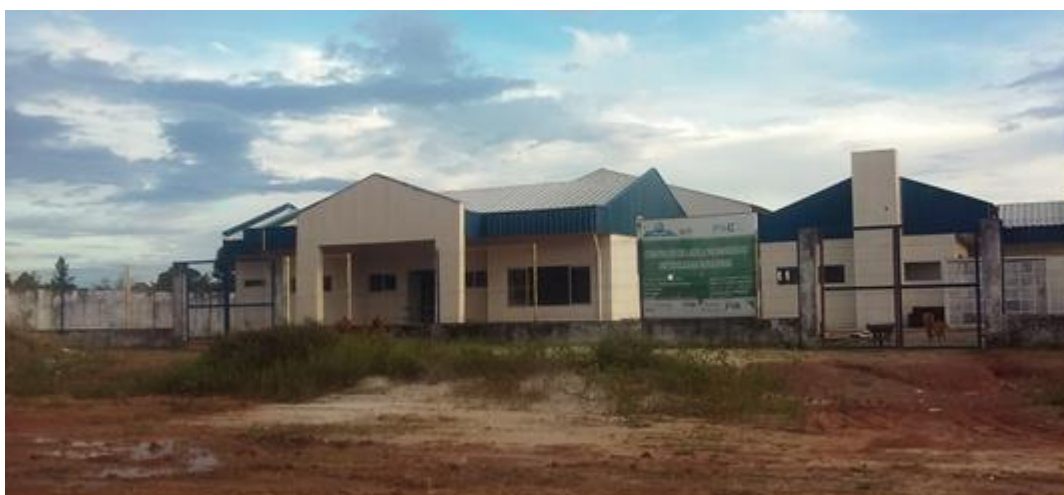
Figura 06: Obra da Creche “Tio Soró”
