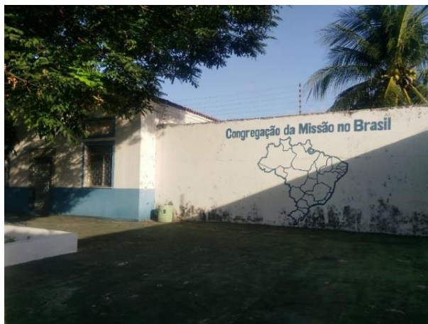
Figura 2 - Pátio interno do Colégio São Vicente de Paulo
