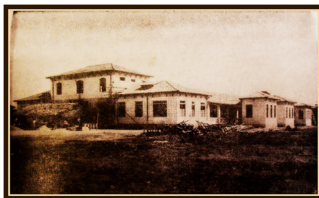
IMAGEM 01- Hospital-Colônia Juliano Moreira em construção, 1923.
