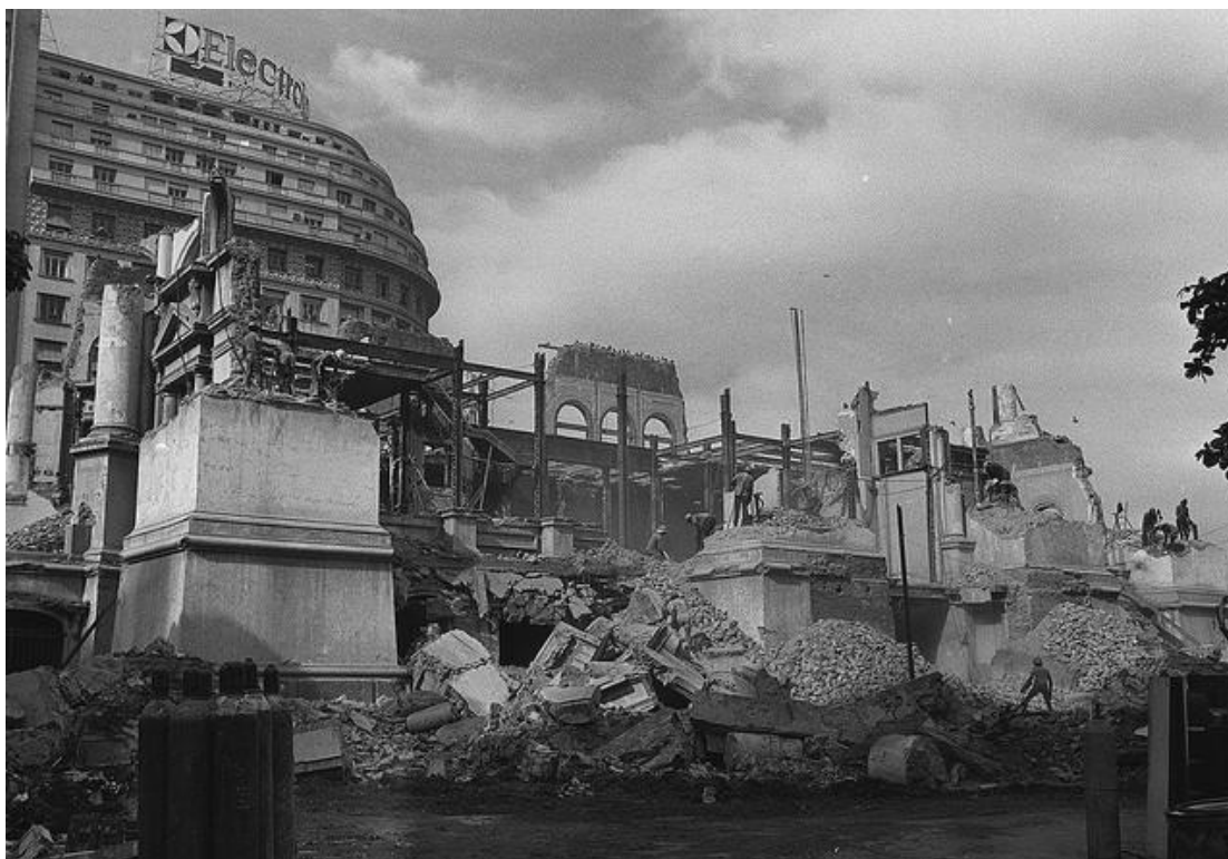
Figura 2: Palácio na fase final da demolição (Arquivo Público do Rio de Janeiro)
