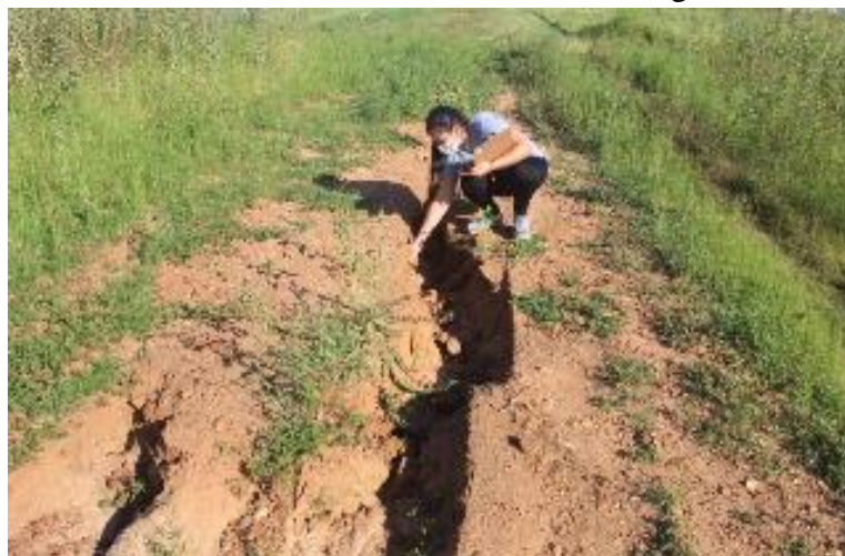
Figura 13 – Processo erosivo em área de loteamento às margens do Riacho Cajazeiras
