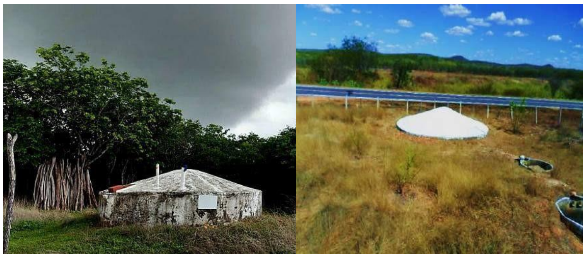
Figura 4 – Cisterna de alvenaria (esquerda) e Cisterna de Enxurrada (direita) na localidade do Sítio Alívio, Solonópole - CE.
