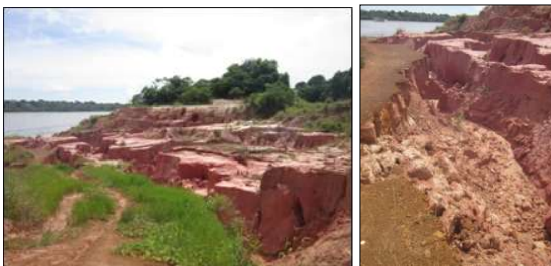
Figura 9 e 10 - Fotos mostrando os processos erosivos em áreas de Argissolos no município de Tefé-AM.
