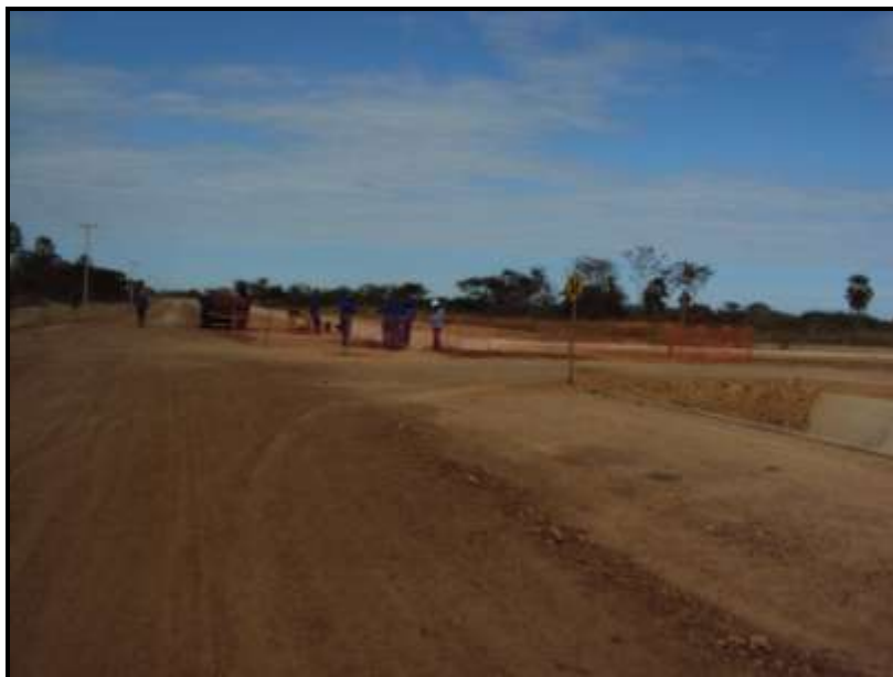
FOTOGRAFIA 02 – Obras da 2ª etapa do perímetro Tabuleiro de Russas (CE). Acervo de Érica Pinheiro, 2013.
