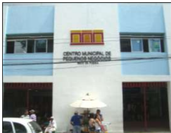
Figura 04 - Novo prédio do Beco da Poeira, instalado na antiga fábrica Thomaz Pompeu de Sousa Brasil. (Fonte: GONÇALVES, 2013).
