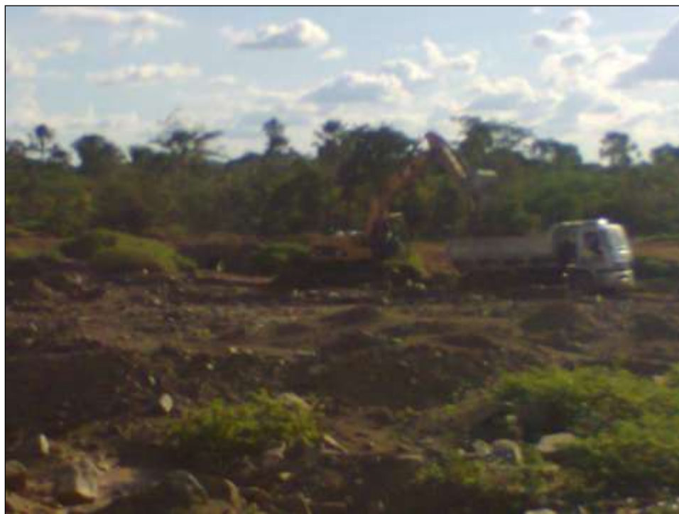
Figura 03 - Máquina colocando as rochas no caminhão. Fonte: Santos (2013)
