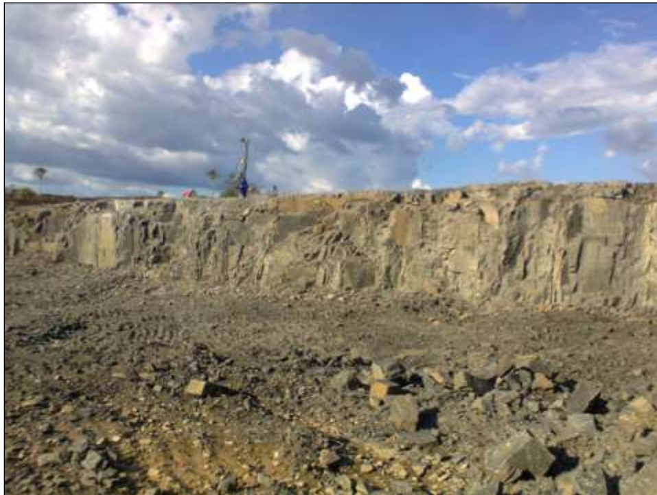
Figura 02 - Perfuração e dinamitação do afloramento de calcário.
