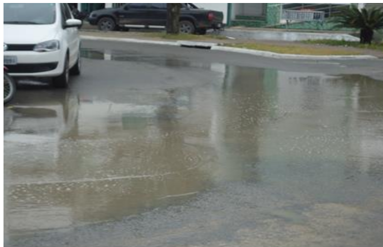
Figura 06: Acúmulo de água pluvial por falta de drenagem eficaz.
