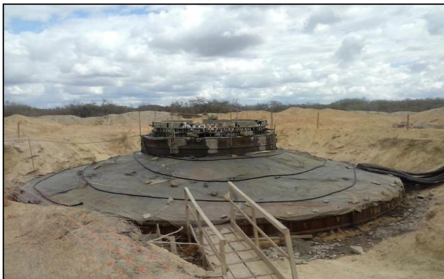
**Figura 7:** Implantação da base de um aerogerador. Fonte: Autores (2016).
