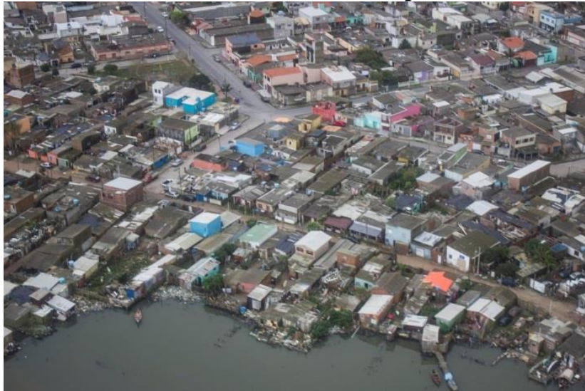
Figura 8: Danos em cobertura de residências da área urbana em função da queda de granizo, na foto acima mostra-se residências cobertas com lona plástica na Vila Dom Bosquinho.
