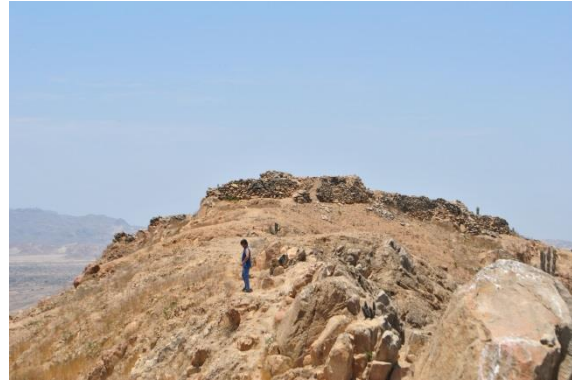
Figura 18. Estruturas em pedra da Fortaleza.
