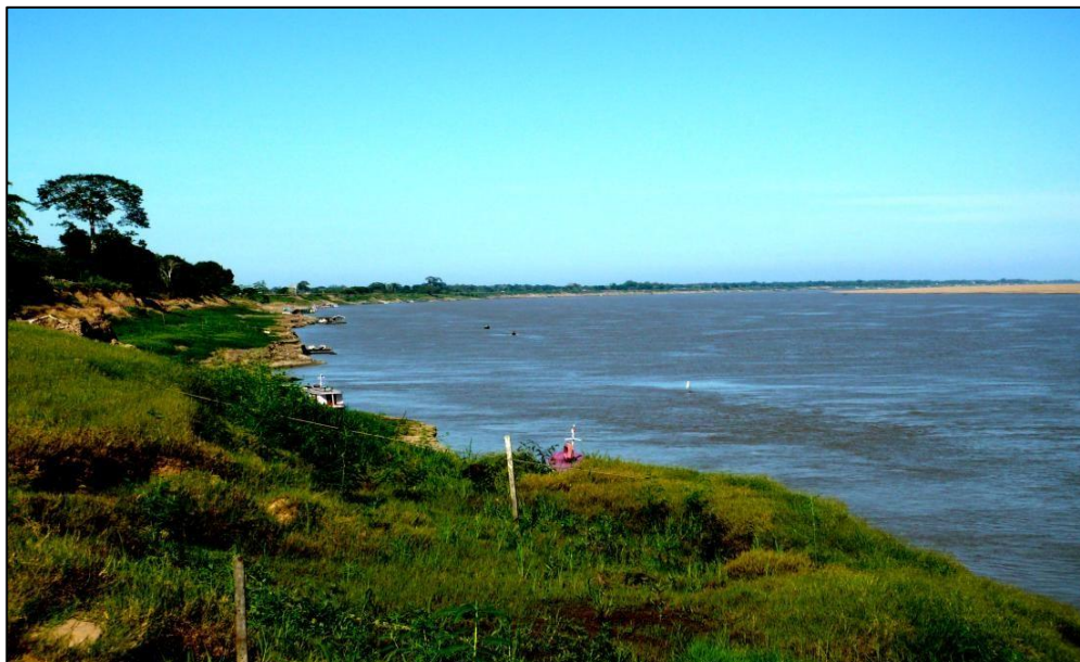
Figura 1: Margem (côncava) de desagregação.
