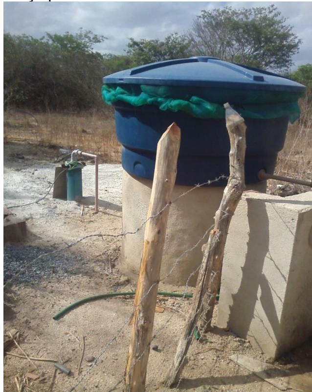
Figura 5: Poço profundo na comunidade de Sombrio- Reriutaba
