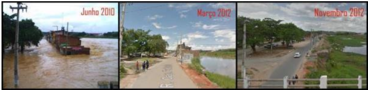
Figura 6 – Rua Cap. Pedro Ivo, vista sobre o viaduto Lucia Paiva
