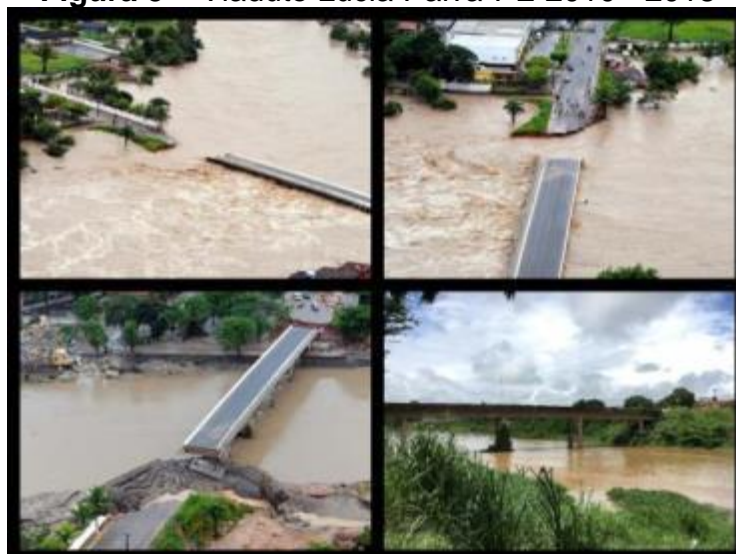
Figura 5 – Viaduto Lucia Paiva-PE 2010 - 2018
