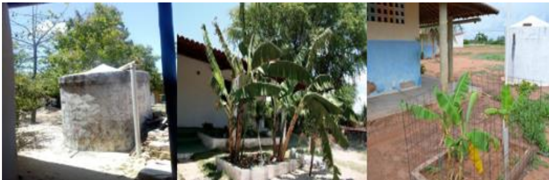
Figura 6 - Cisternas para captação da chuva e Canteiros bio-sépticos implantados na comunidade pesqueira da Requenguela, Icapuí -CE Fonte: Autores, 2018 e BRASIL (2019).
