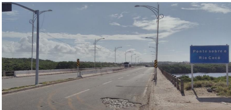
Figura 3 - Ponte sobre o Rio Cocó no bairro de Sabiaguaba. Fonte: Bentemuller (2019)
