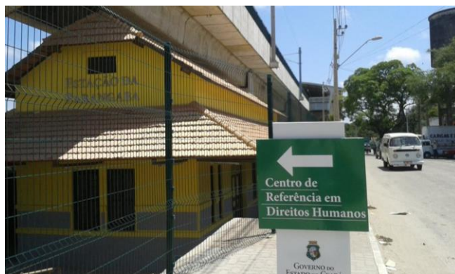
Figura 7 - Antiga estação da Parangaba sob trecho do VLT (2019). Fonte: Diário do Nordeste
