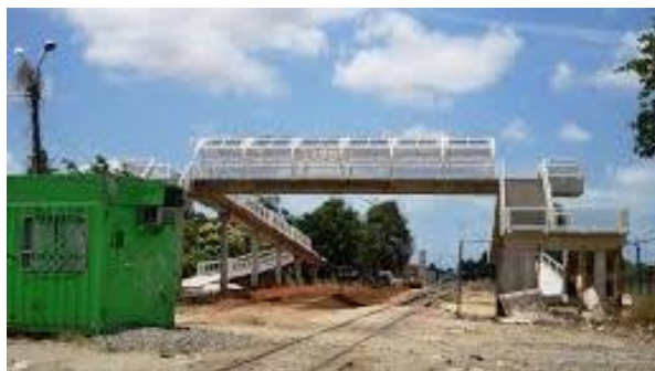
Figura 8 - Passarela no lugar da antiga estação do Mondubim Fonte: Fortaleza em Fotos e Fatos
